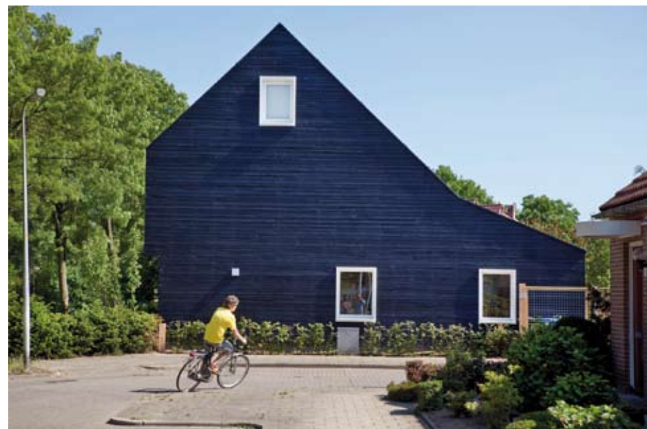
De marginale uitstraling en de vrij gesloten kop van de woningen gaven de wijk op beeldbepalende locaties een onaangenaam karakter. Door de kopwoning op die plaatsen te vergroten en te voorzien van een nieuwe zwarthouten gevel is een eigentijdse kantige contour ontstaan, die verwijst naar de boerenschuren in het buitengebied van Zwolle. Het extra raam vergroot de sociale controle. Fotograaf Leonard Faustle
